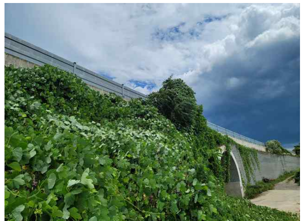
상부 성토부 전경
