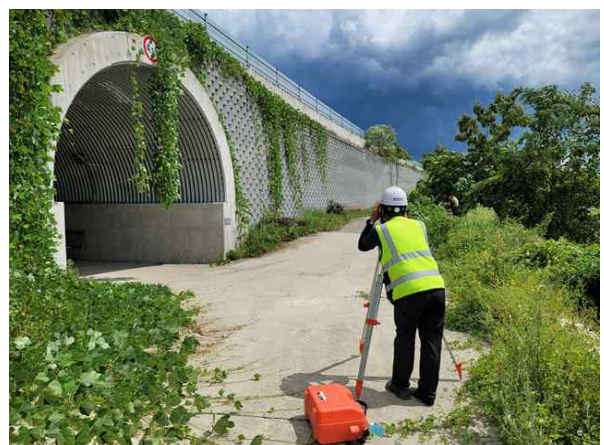
광파기를 이용한 경사도 측정
